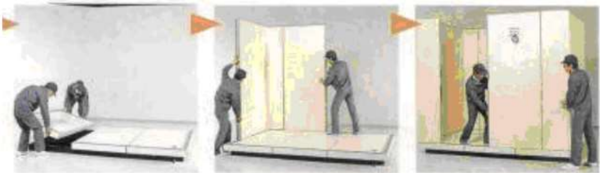
Lắp ghép panel kho lạnh
